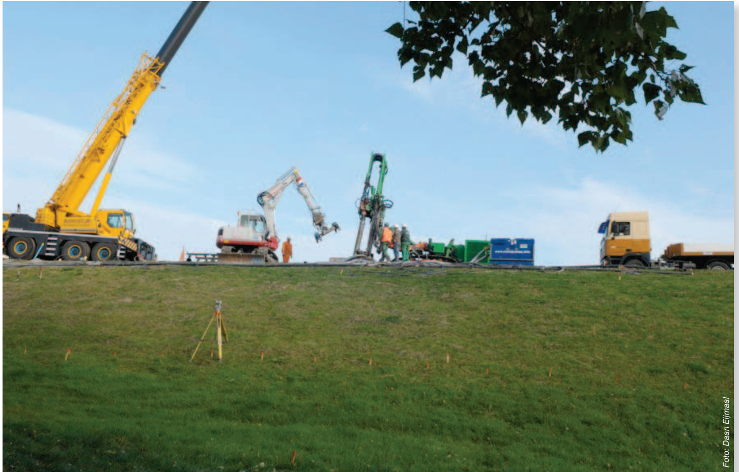
Boorinstallatie voor de 27 m lange dijkdeuvels.
